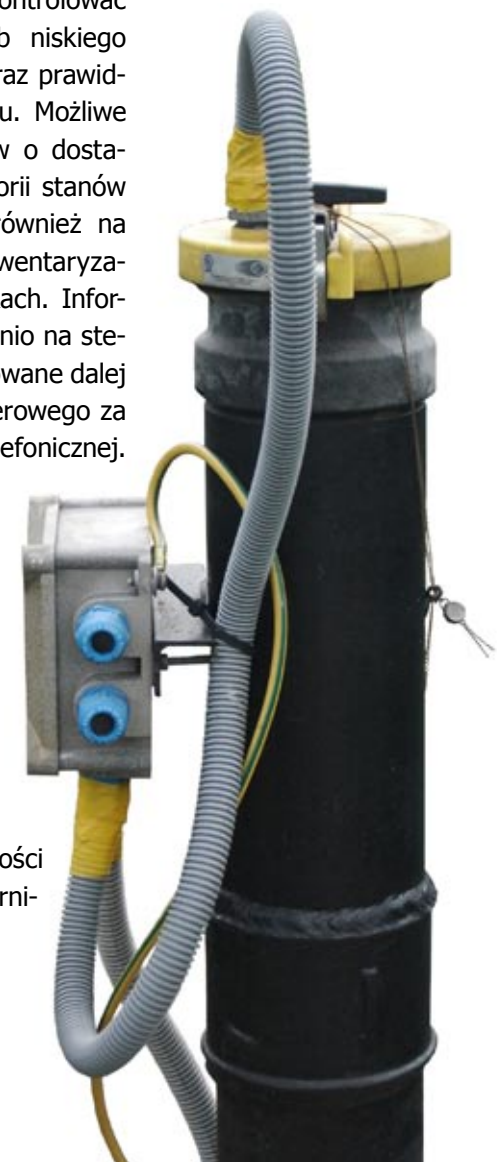
Króciec z zainstalowaną sondą pomiarową
