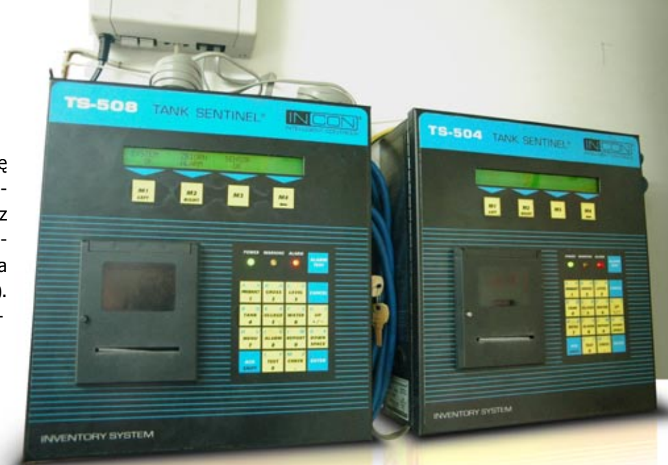
Panel sterujący ze sterownikami sond pomiarowych
